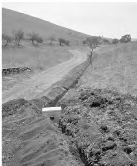
Fig. 13 - Trincea realizzata per la posa del cavidutto, alla fine delle operazioni di scavo, con sistemazione dei pozzetti di ispezione.
