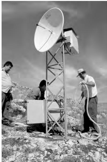
Fig. 16 - Sistemazione della parabola per il collegamento con ponte radio tra la collina di Lamalunga ed il Museo Archeologico di Altamura.
