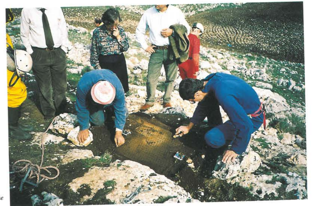
Fig. 8 La protezione attuale sulla imboccatura del pozzo di accesso alla cavità.
